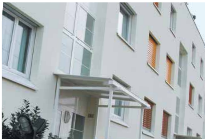
Die Fassade des gleichen Gebäudes wurde daraufhin saniert und mit einem zweimaligen StoColor Fungasil-Anstrich versehen. Das Bild der nach wie vor einwandfreien Fassade entstand 6 Jahre später.
